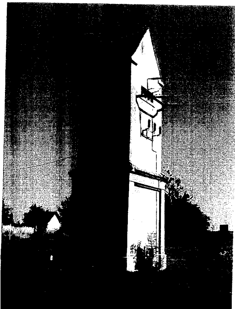
Fot. 7 Podstacja transformatorowa
